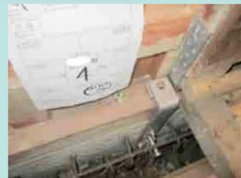
基礎補強を行った場合、基礎配筋時に基礎と緊結できる柱脚金物を埋め込むこともあります。
