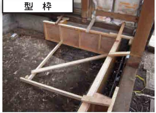
配筋の周りにコンクリートを流し込むための型枠を設置します。
