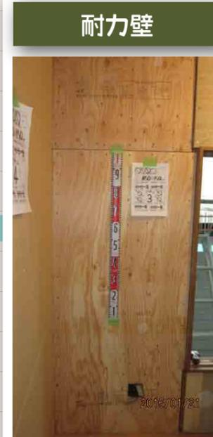
構造用パネルを施工。(設計によっては石膏ボードを施工します)
