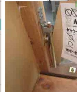
Step1での構造計算を元に、柱脚・柱頭に金物を取り付けます。力がかかりやすい柱には強い力を持った金物を取り付けます。
