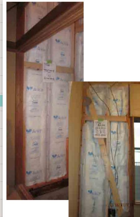
断熱材を施工します。両筋交の場合、奥側にある筋交いは写真のように断熱材で隠れてしまいます。
