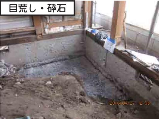
抱き合わせ基礎のコンクリートが吸着しやすいように基礎側面を細かく傷つけます。
