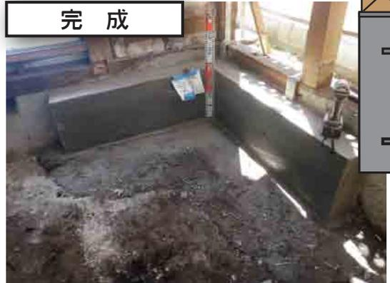
コンクリートを流し込み、固まったら型枠を外して完成です。
